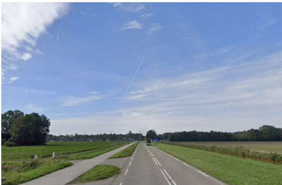
Wegprofiel van de Espelerweg ter hoogte van het plangebied (links toerit zichtbaar), kijkend in westelijke richting
