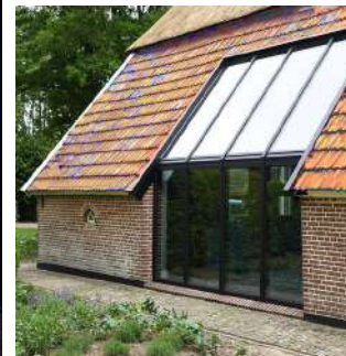
↖ glazen pui aan de achterkant
