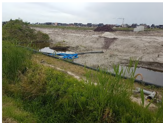
Figuur 3.13: Werkzaamheden ten oosten van het perceel.
