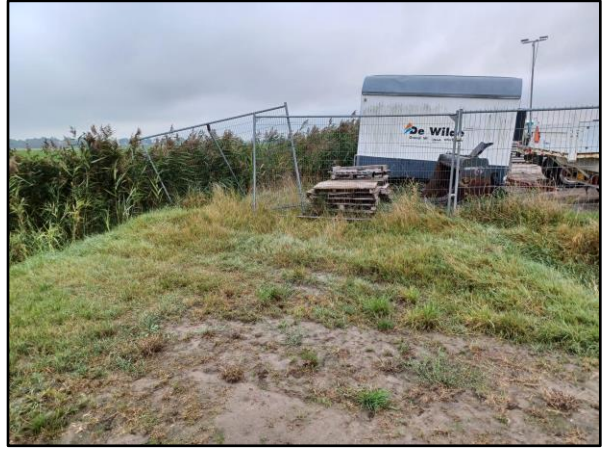
Foto 8: Dam aan de noordoostzijde van de onderzoekslocatie.
