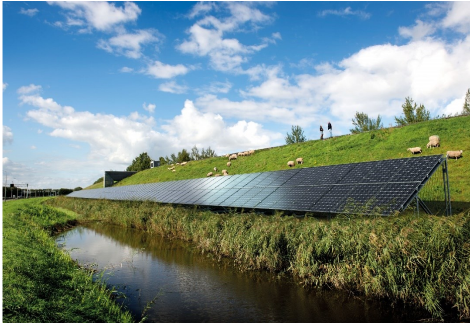
Foto: panelen langs waterloop
