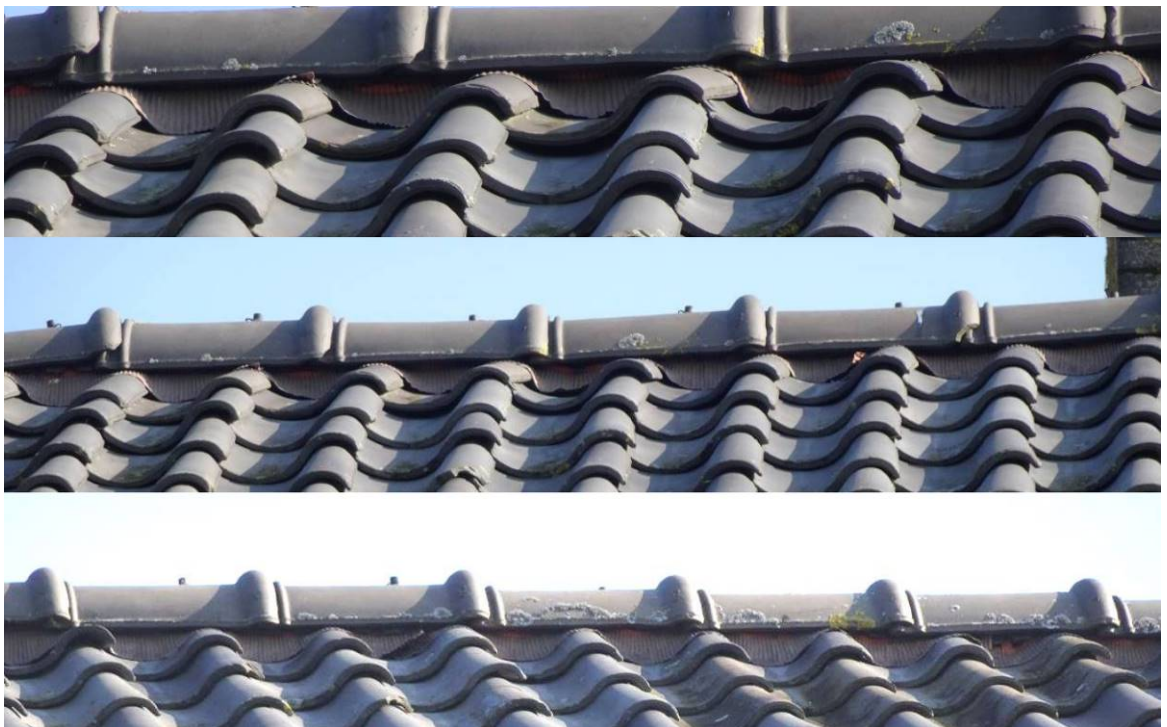
Figuur 5. Dichte dakaansluitingen aan de Waterkant 61 te Ens doordat de dakpannen op de top zijn afgesloten met doek en daardoor geen ruimte bieden aan verblijfplaatsen voor vleermuizen of gierzwaluwen.
