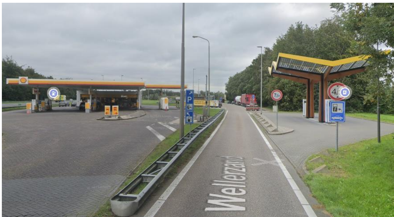
Afbeelding 3.1: Het verzorgingsgebied Wellerzand gezien vanaf de inrit (bron: google maps)
