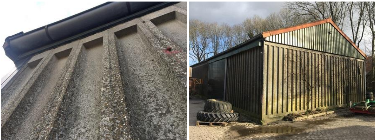
De gladde afwerking van van de schuur, zonder holle ruimtes, maakt de schuur tot een ongeschikte verblijfplaats voor vleermuizen.
