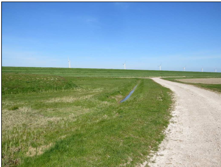
Toegansweg windturbines met de negen meter hoge IJsselmeerdijk.
