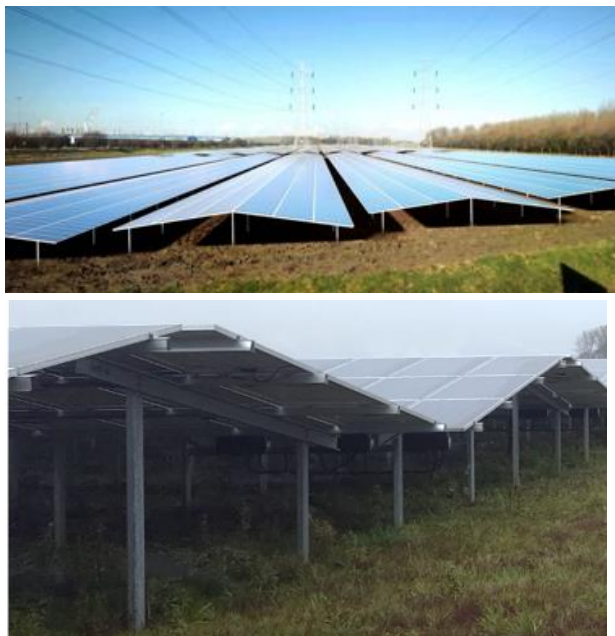
Figuur 3.2 Voorbeelden aanzicht panelen met oost-west oriëntatie
