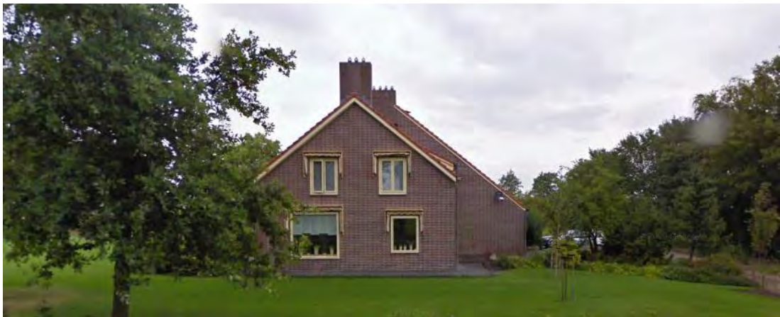
Fig. 1. Bestaande situatie, vooraanzicht
