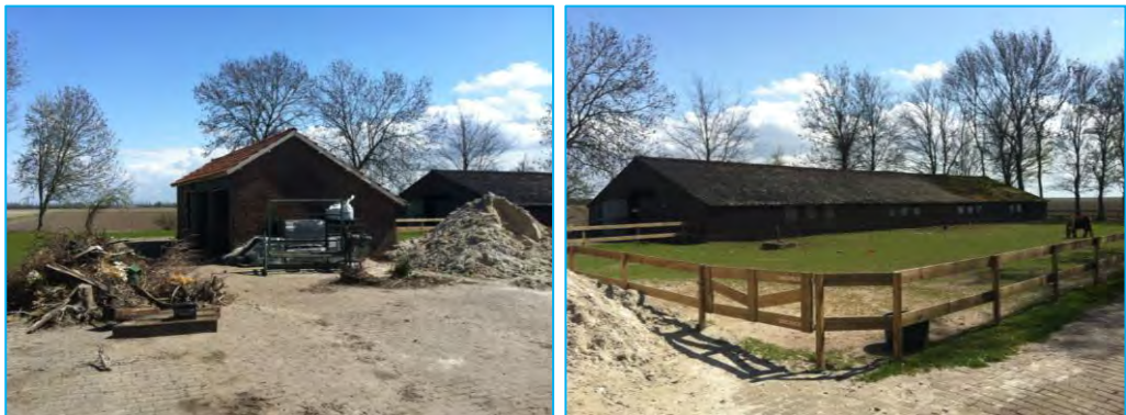
De te slopen bebouwing
