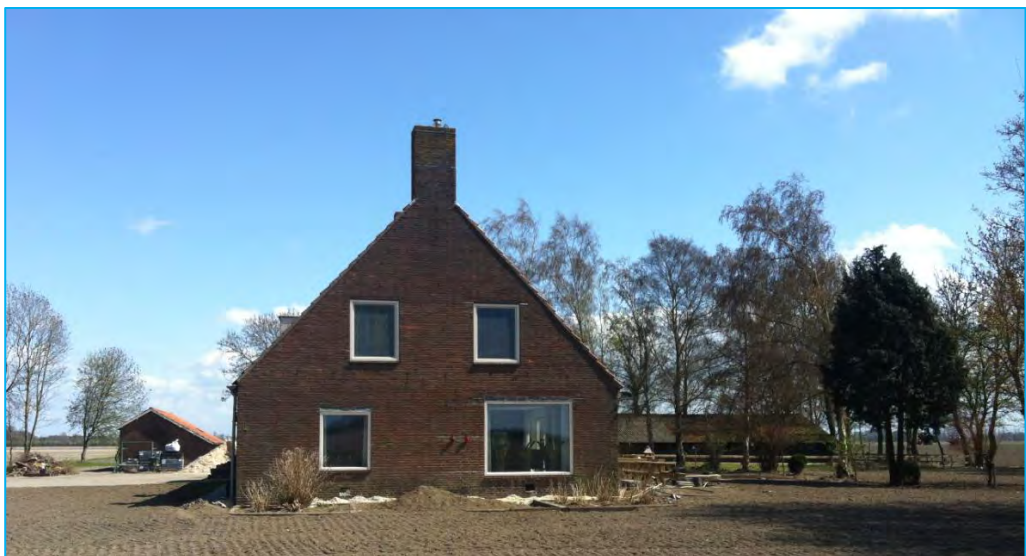
Bestaande hoofdgebouw met op achtergrond aan weerszijden zichtbaar de te slopen bebouwing
