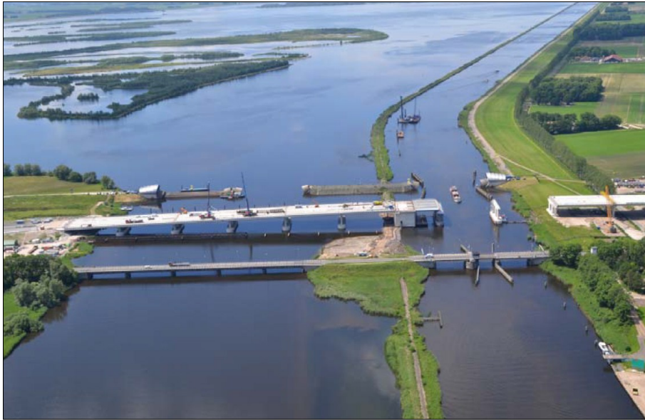
Figuur 2. Luchtfoto van de brug in aanbouw
