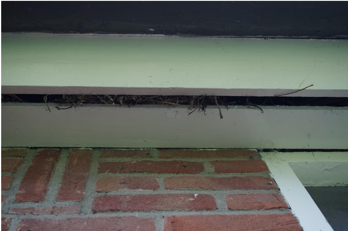
Figuur 5.2. Sporen van nestmateriaal tussen de eerste rij dakpannen en dakgoot.
