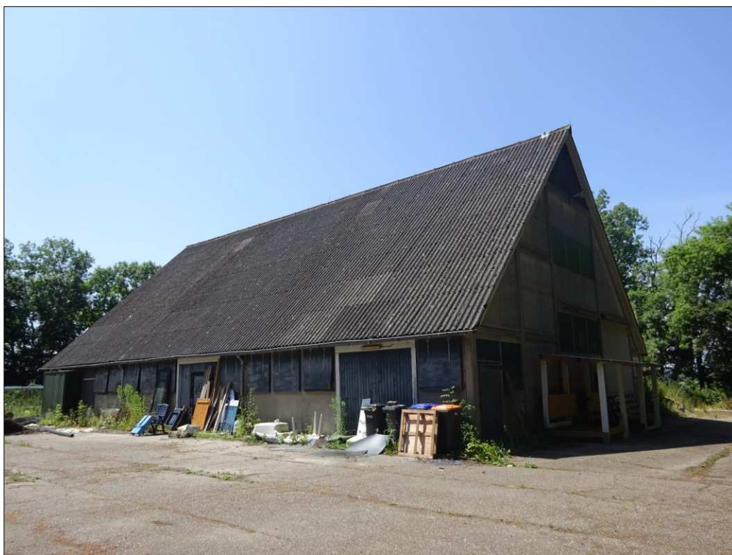
Figuur 1.2 Noordoostzijde van de schuur.
