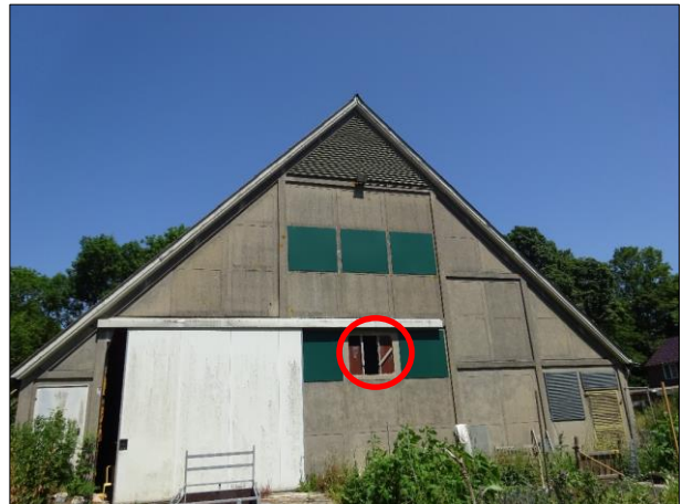
Figuur 4.2. Opening in zuidgevel.
