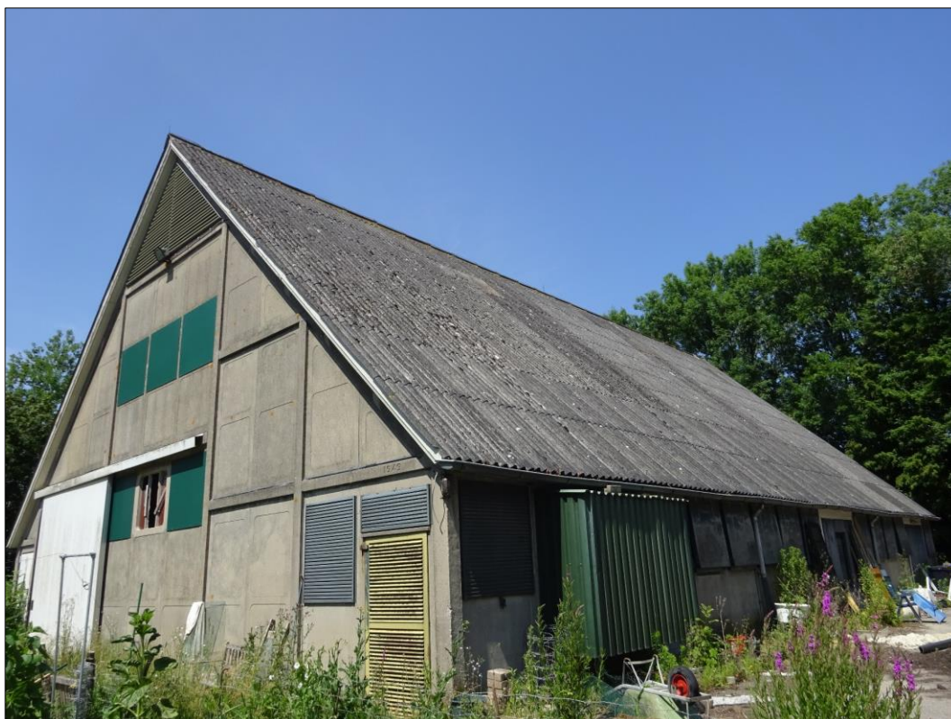
Figuur 1.5 Zuidoostzijde van de schuur.
