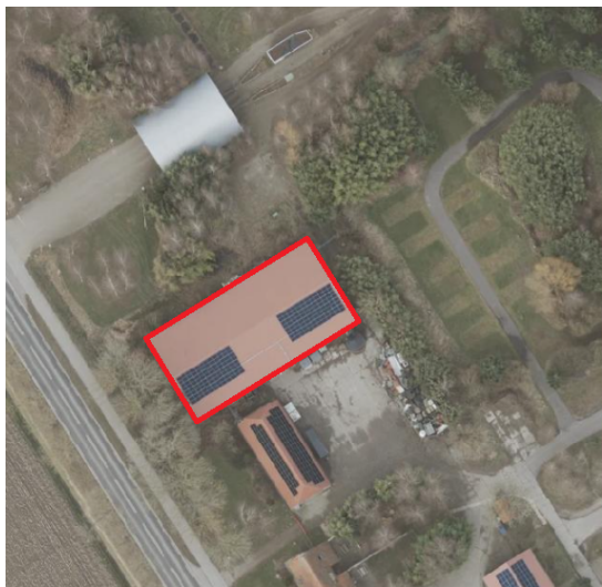
Locatie bestaande Witlofloods
