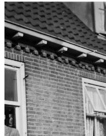
oorspronkelijke bakgoot en ramen, let op accent in metselwerk
