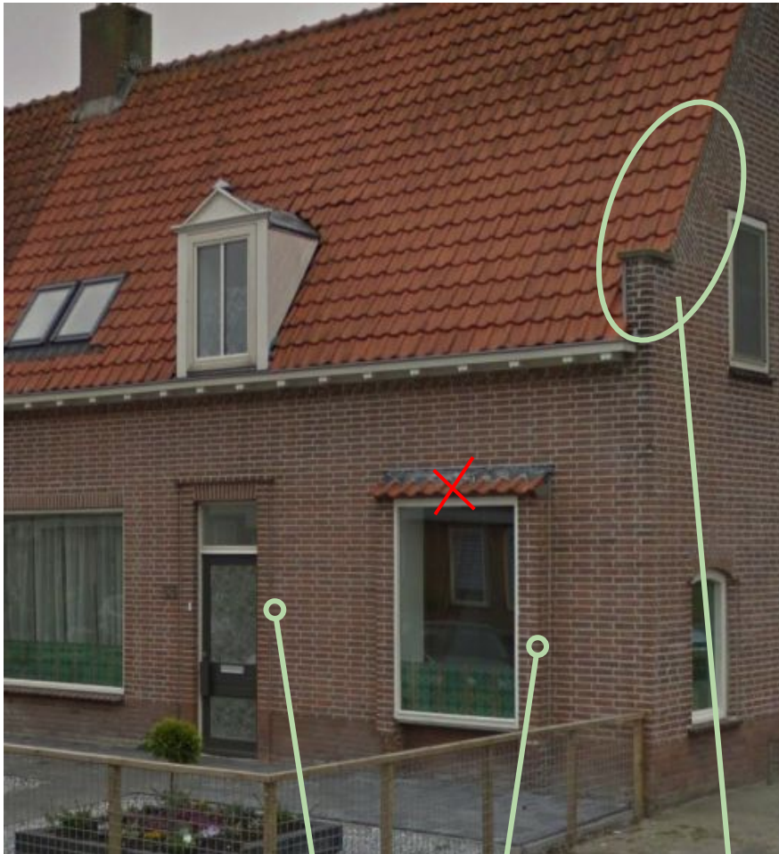
hoekwoning Rietstraat - Moerasandijviestraat, huidige situatie
