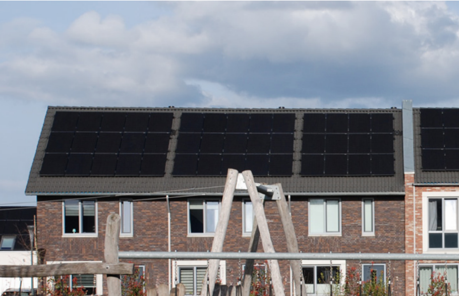
geen 'willekeurige positie', maar eenduidig geplaatst in gesloten vlakken all black (zelfde kleur als het dak)
