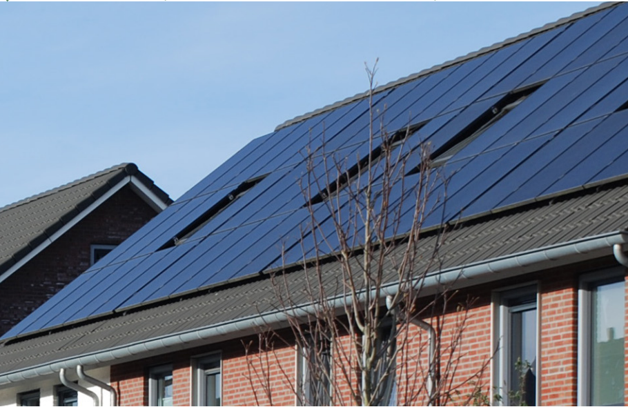
geen 'willekeurige positie', maar eenduidig geplaatst in gesloten vlakken all black (zelfde kleur als het dak)
