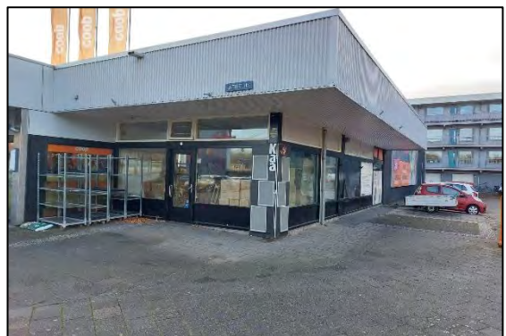
Afbeelding 2.5. Leegstaande winkelpand aan de westzijde welke uitgebouwd dient te worden.
