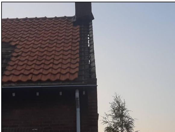
Figuur 7. Ongeschikt gemaakt woonhuis.
