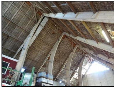
Figuur 15. Nok rechter schuur/ werkplaats.
