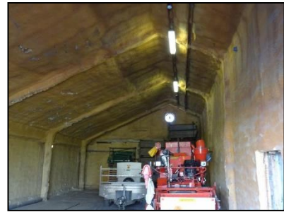
Figuur 16. Opslag/stalling kleine schuren, afgewerkt met purschuim.
