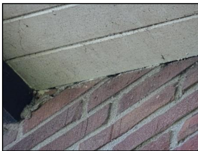
Figuur 17. Openingen onder overschot woning.
