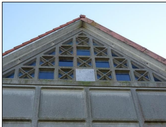
Figuur 10. Afwerking gevel schuur.
