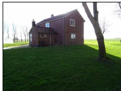
Figuur 8. Te slopen woning op de onderzoekslocatie.
