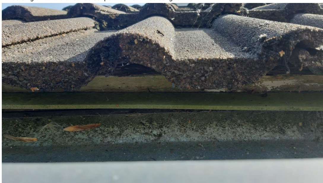
Afbeelding 6: Ruimte onder de dakpannen vanuit de dakgoot.
