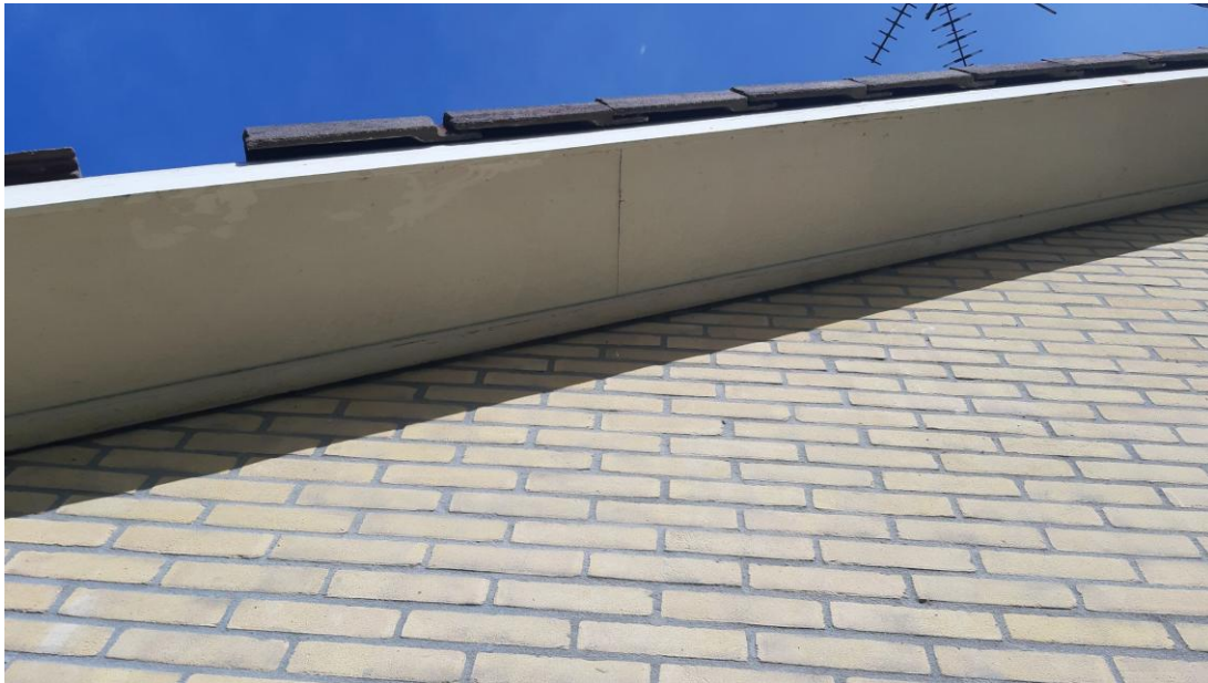
Afbeelding 10: Missende dakpan en ruimte tussen de muur en boeidelen.
