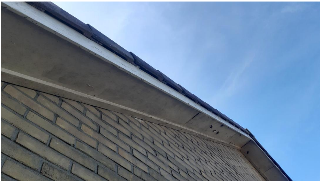
Afbeelding 12: Ruimte tussen de dakpannen en boeidelen.
