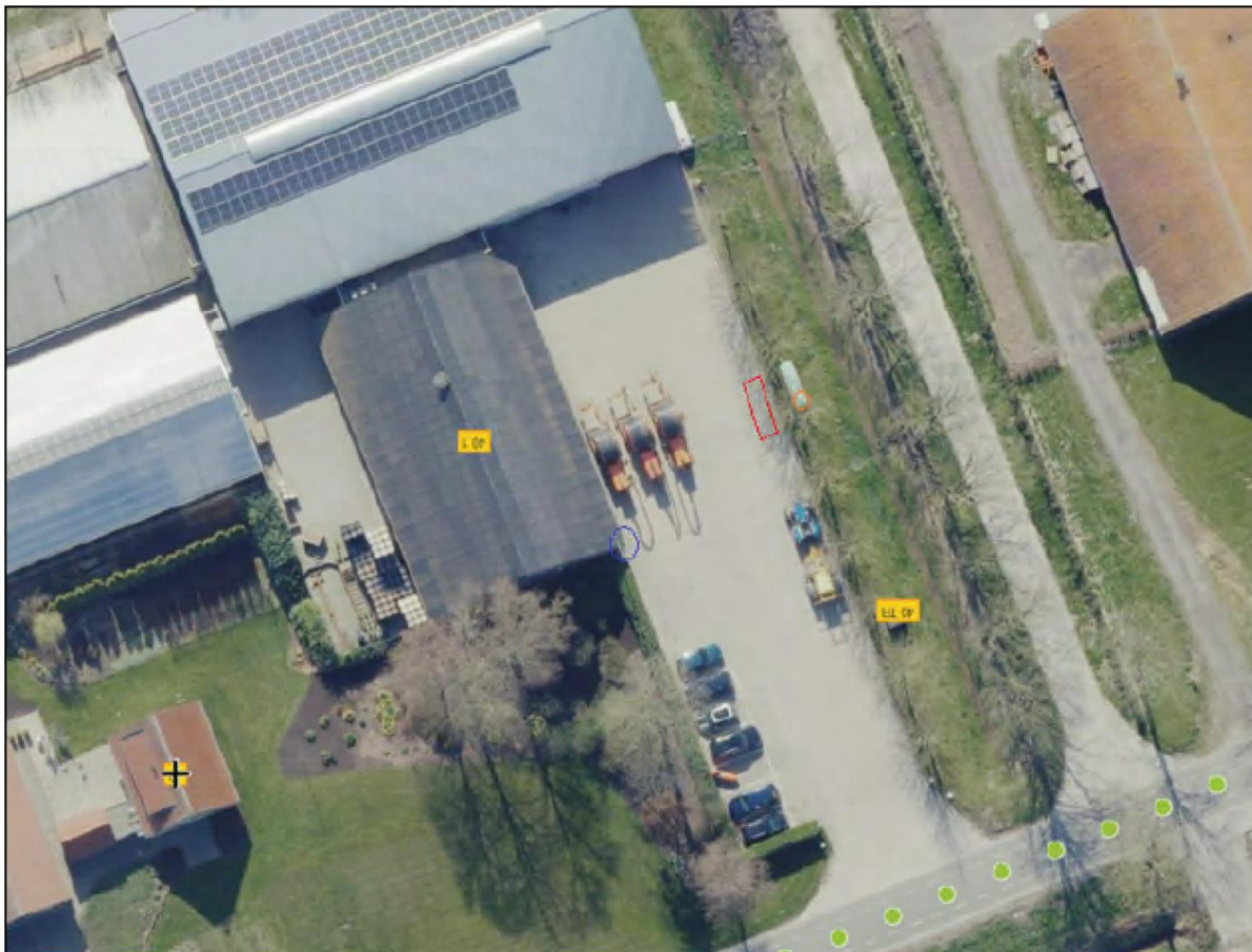
Afbeelding 5.1 Luchtfoto Zwartemeerweg 40 (Bron: Street Smart)
