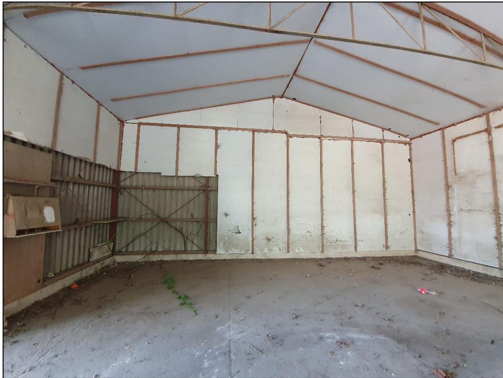
Figuur 4 Weergave van de sandwichpanelen in schuur D op de planlocatie.
