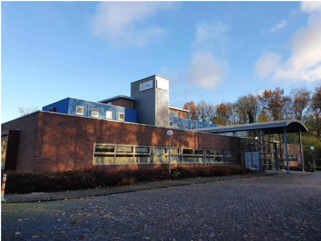
Figuur 2. Zorggebouw Emmeloord.
