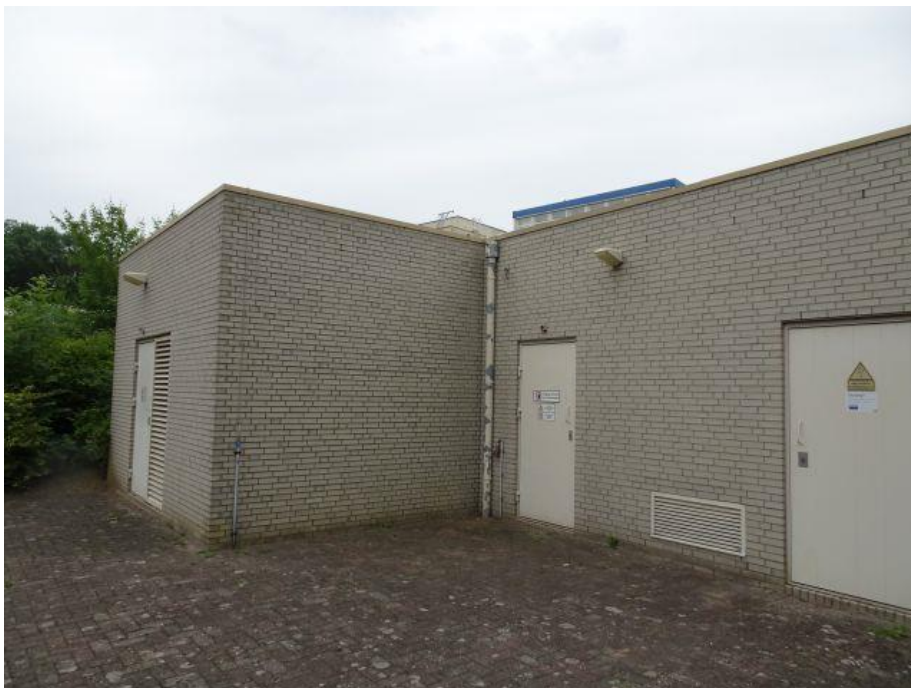
Trafo (N) aan de parkeerplaats
