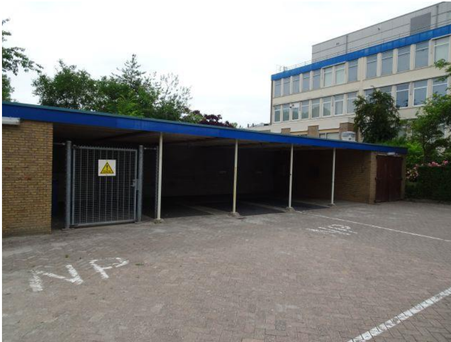
Gebouw K de berging
