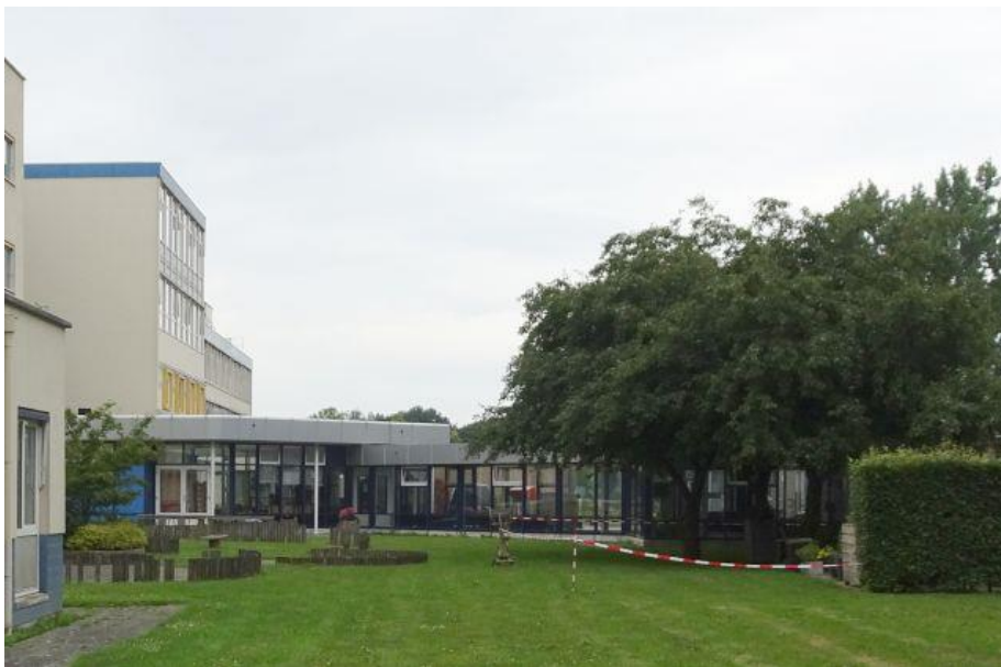
Gebouw L de entree (laagbouw)
