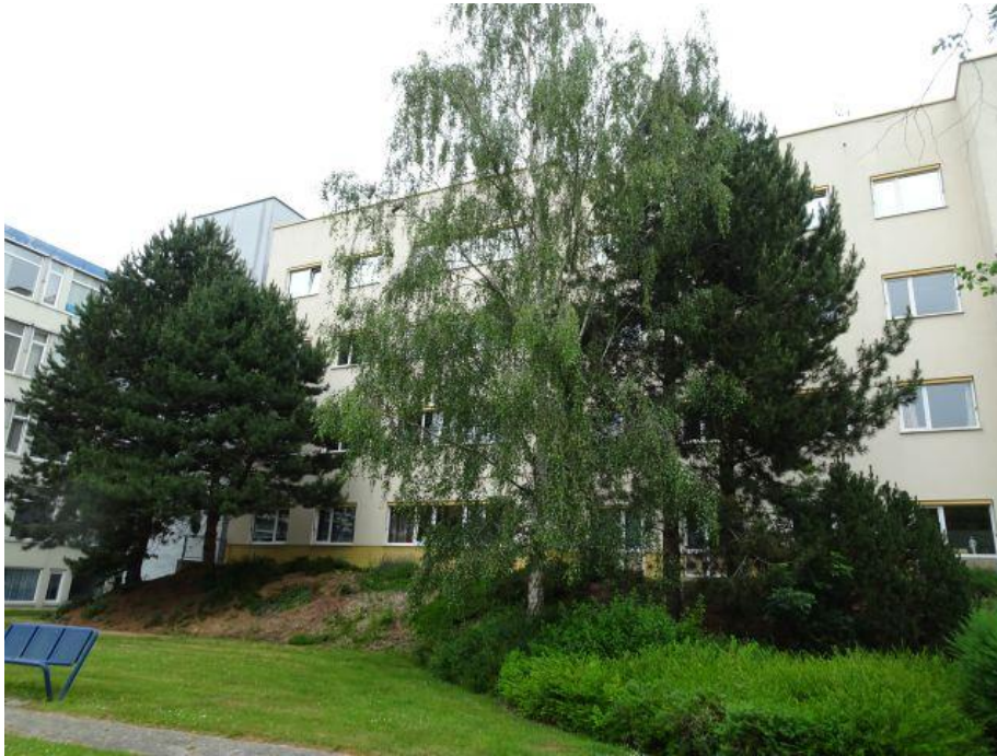
Gebouw N hoog gedeelte
