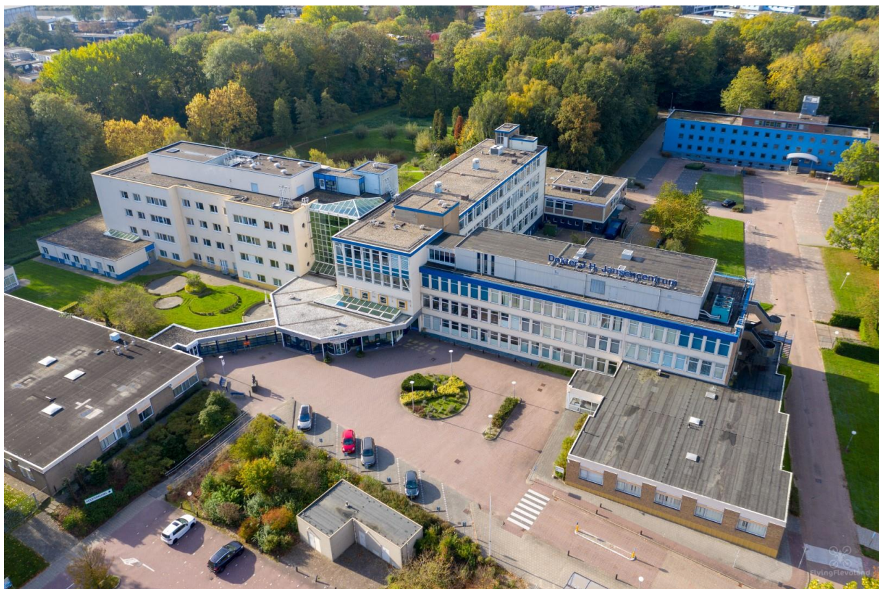
Afbeelding 2.1: Huidige situatie Dr. Jansencentrum gezien vanuit de lucht richting het zuidwesten (bron: L. de Graaff via https://www.emmeloord.info/ziekenhuis ).
