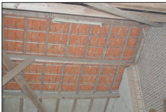
Afbeelding 2.4. Binnenzijde dak van de schuur.
