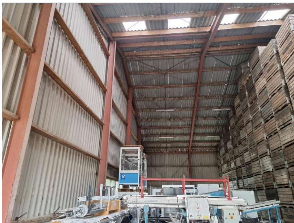
Figuur 2 De binnenzijde van de te saneren schuur.
