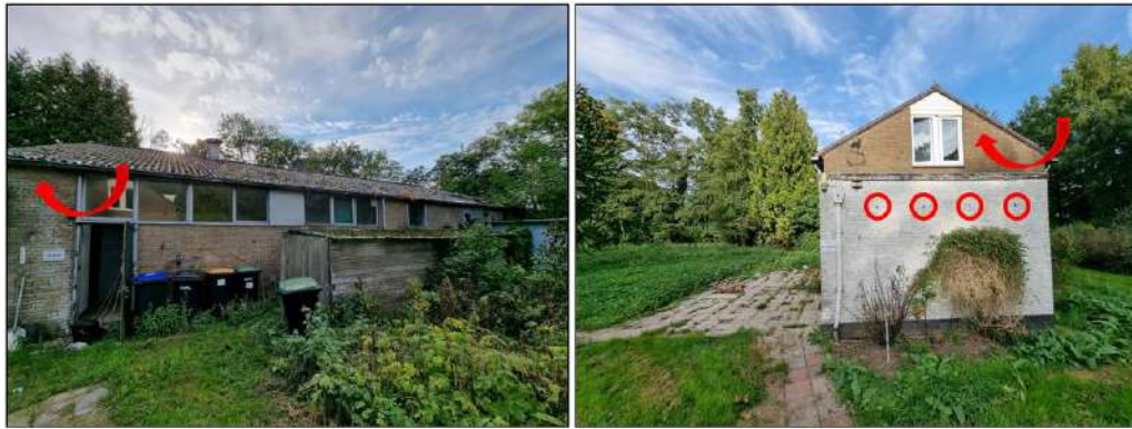
Figuur 5 De aanwezige bebouwing op het perceel van de Drietoerensweg 40-2 met rood omcirkeld of aangegeven enkele invliegopeningen geschikt voor vleermuizen.
