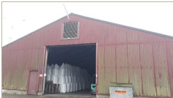
Figuur 2.4: De te slopen schuur (2)
