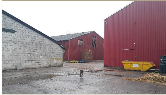
Figuur 2.3: Van links naar rechts; schuur (1), de te slopen schuur (2) en te behouden kapschuur (3)
