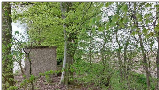
Afbeelding 1.12. Transformatorhuisje in bosschage
