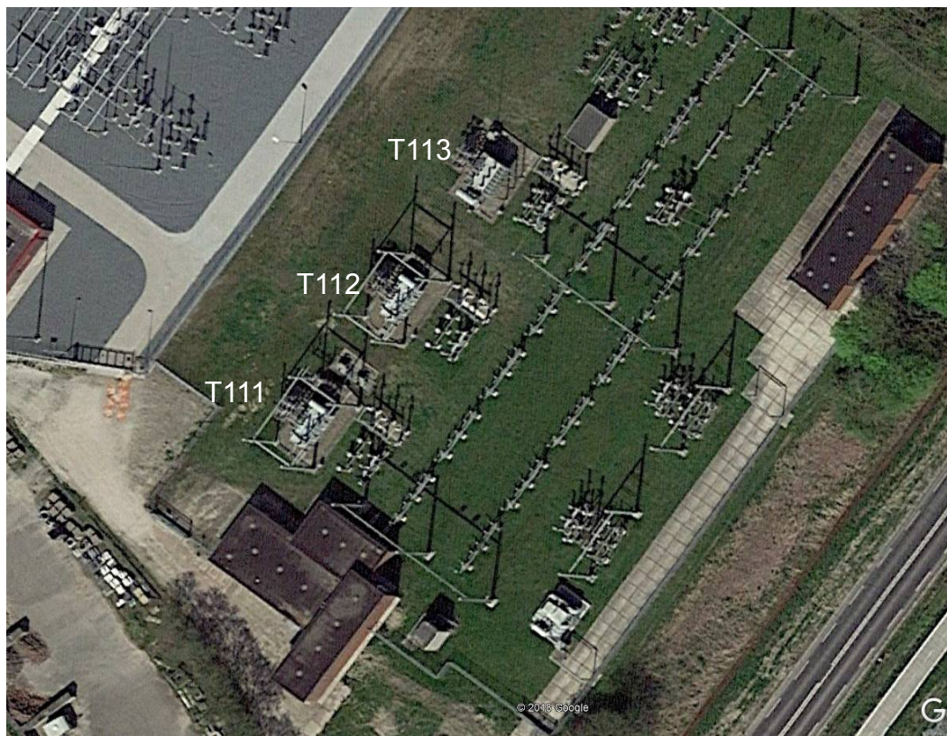
f2.2 Situering huidige transformatoren (T111, T112 en T113) op het onderstation
