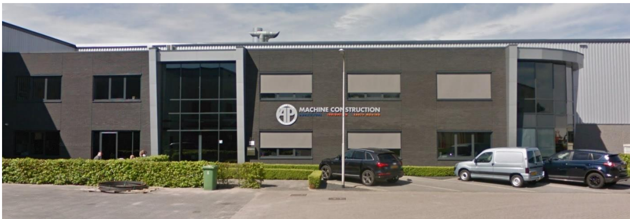
Fig.2: Kantoorgebouw van AP-machinebouw gevestigd aan de Ambachtstraat (bron: google streetview)
