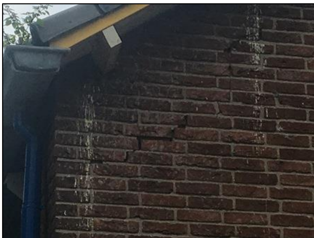
Uitwerpselen van spreeuwen onder de dakpannen in deelgebied Buitenom 1.
