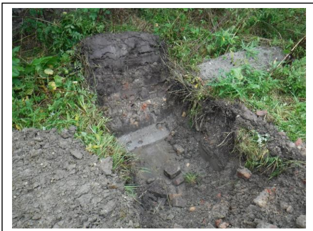
Foto: Inspectiegat G06
