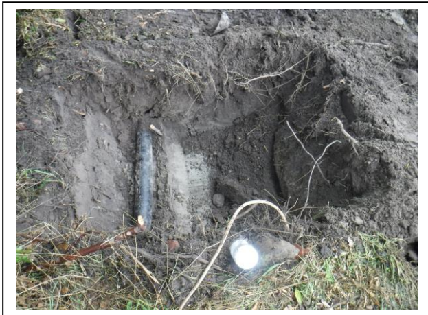
Foto: Inspectiegat G04
