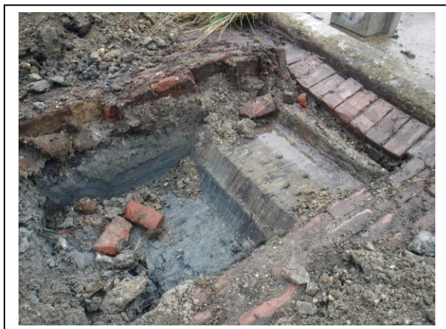
Foto: Inspectiegat G07
