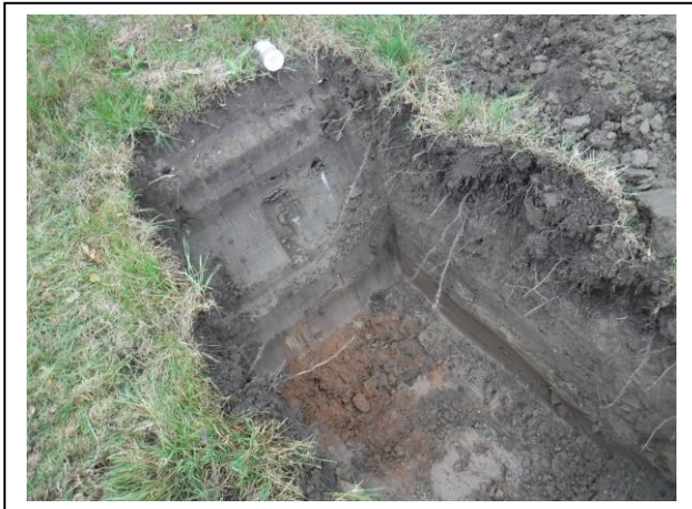
Foto: Inspectiegat G02
