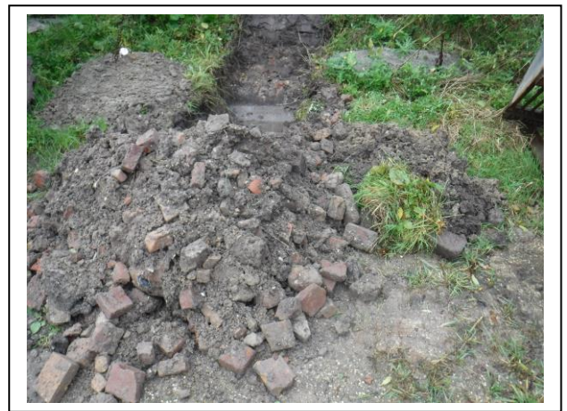
Foto: Inspectiegat G06
