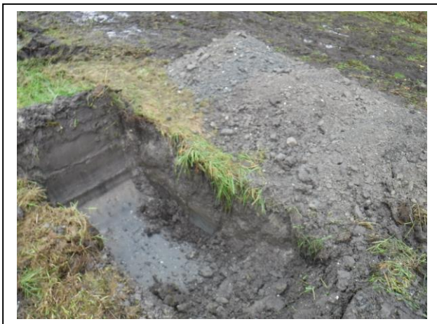
Foto: Inspectiegat G11
