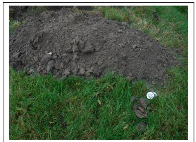
Foto: Inspectiegat G03
