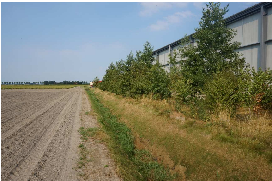
Figuur 2.4. Overzicht zuidwestgrens onderzoeksterrein vanuit zuiden, met rechts op foto bestaande bedrijfsloods.
