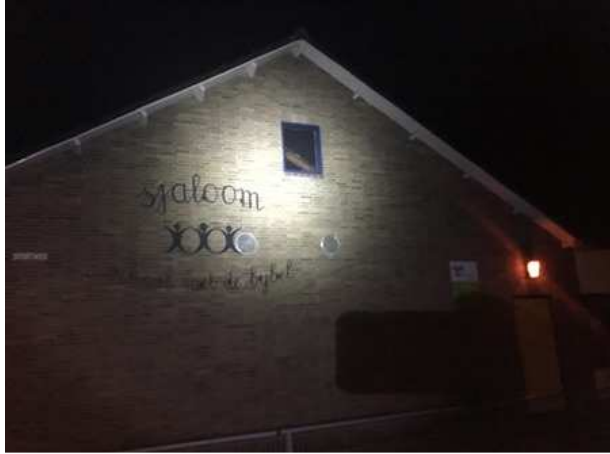
Detailopname van een kopgevel van het schoolgebouw. Er zijn in de buitengevel geen potentiële invliegopeningen zichtbaar.
