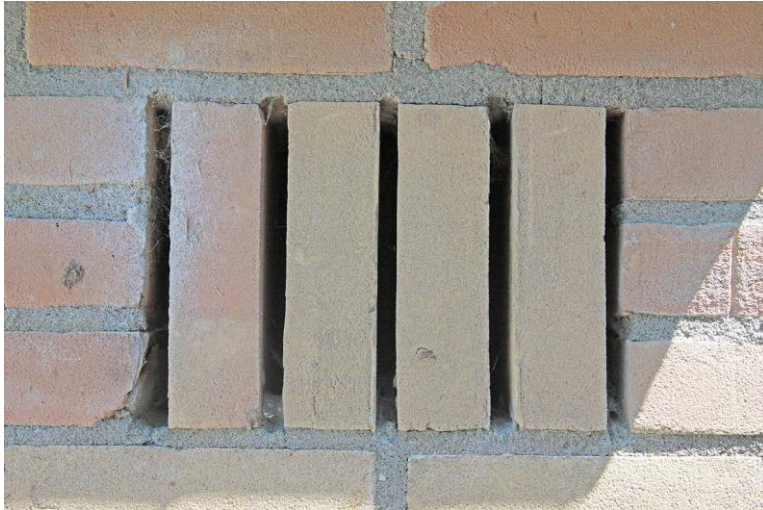
Figuur 4.1 Openingen t.b.v. ventilatie van spouwmuur.
