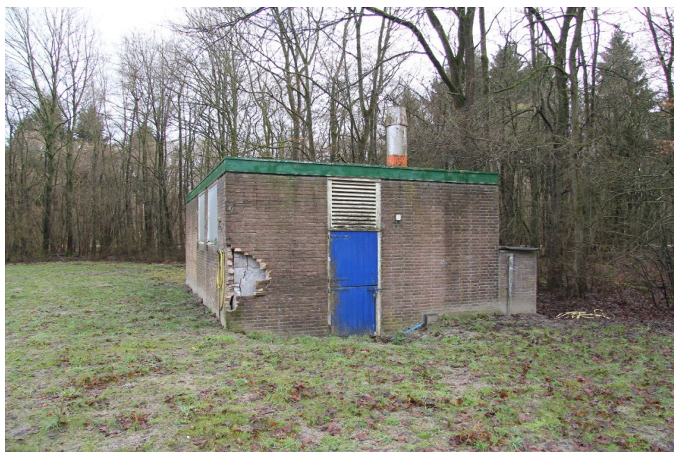
Figuur 6. Voormalige technische gebouw.
