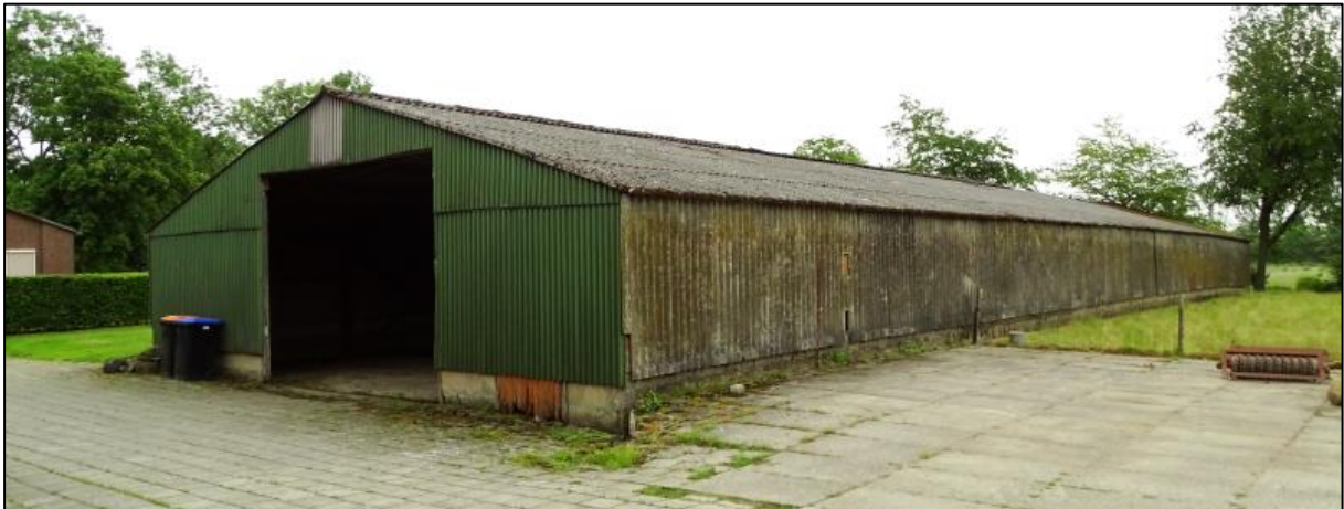
Figuur 2.2. Overzichtsfoto van de voorzijde van één van de voormalige kippenschuren (1) gezien vanuit zuidelijke richting.
