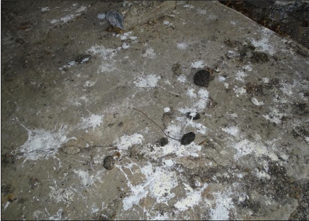
Figuur 5.4. Poepsporen en braakballen van een kerkuil aangetroffen in schuur 2.
