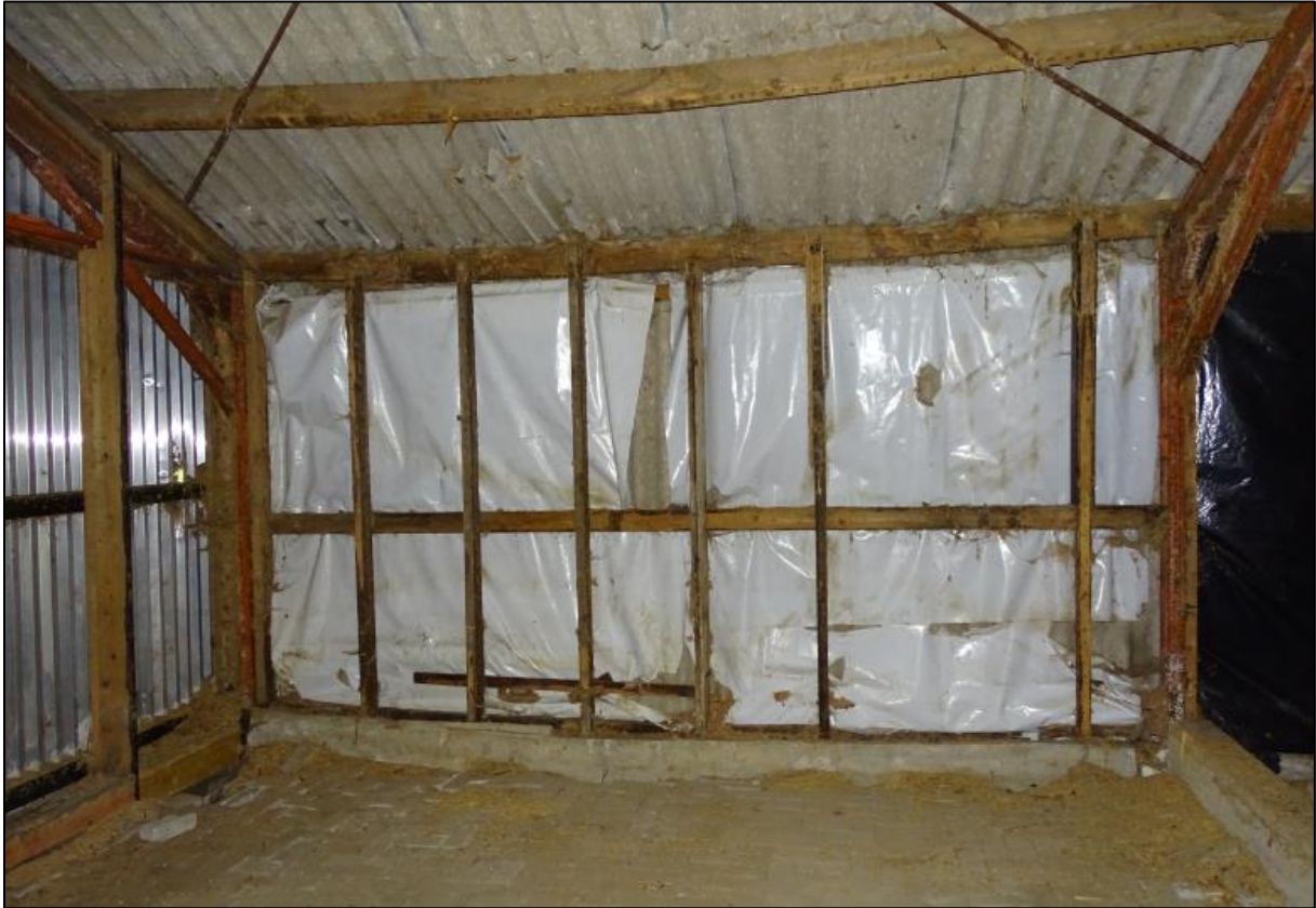
Figuur 5.6. Binnen aanzicht van schuur 3, bestaande uit golfplaten en plastic wanden.
