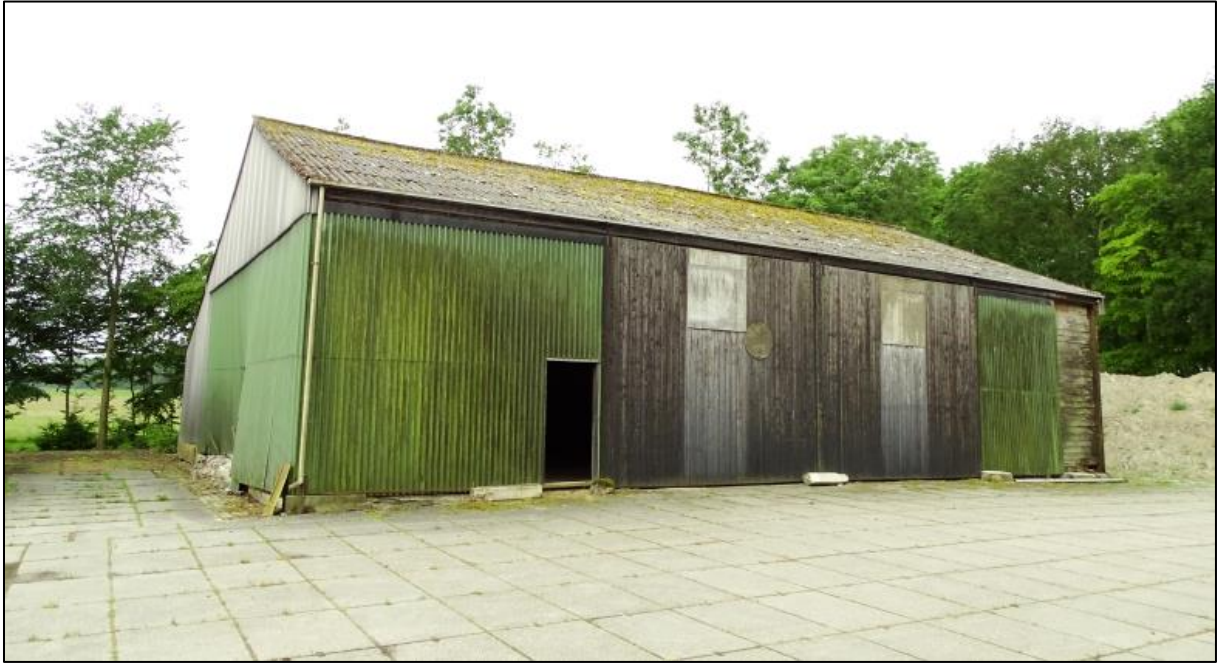
Figuur 2.5. Overzichtsfoto van de van asbest te saneren schuur (3) gezien vanuit noordelijke richting.
