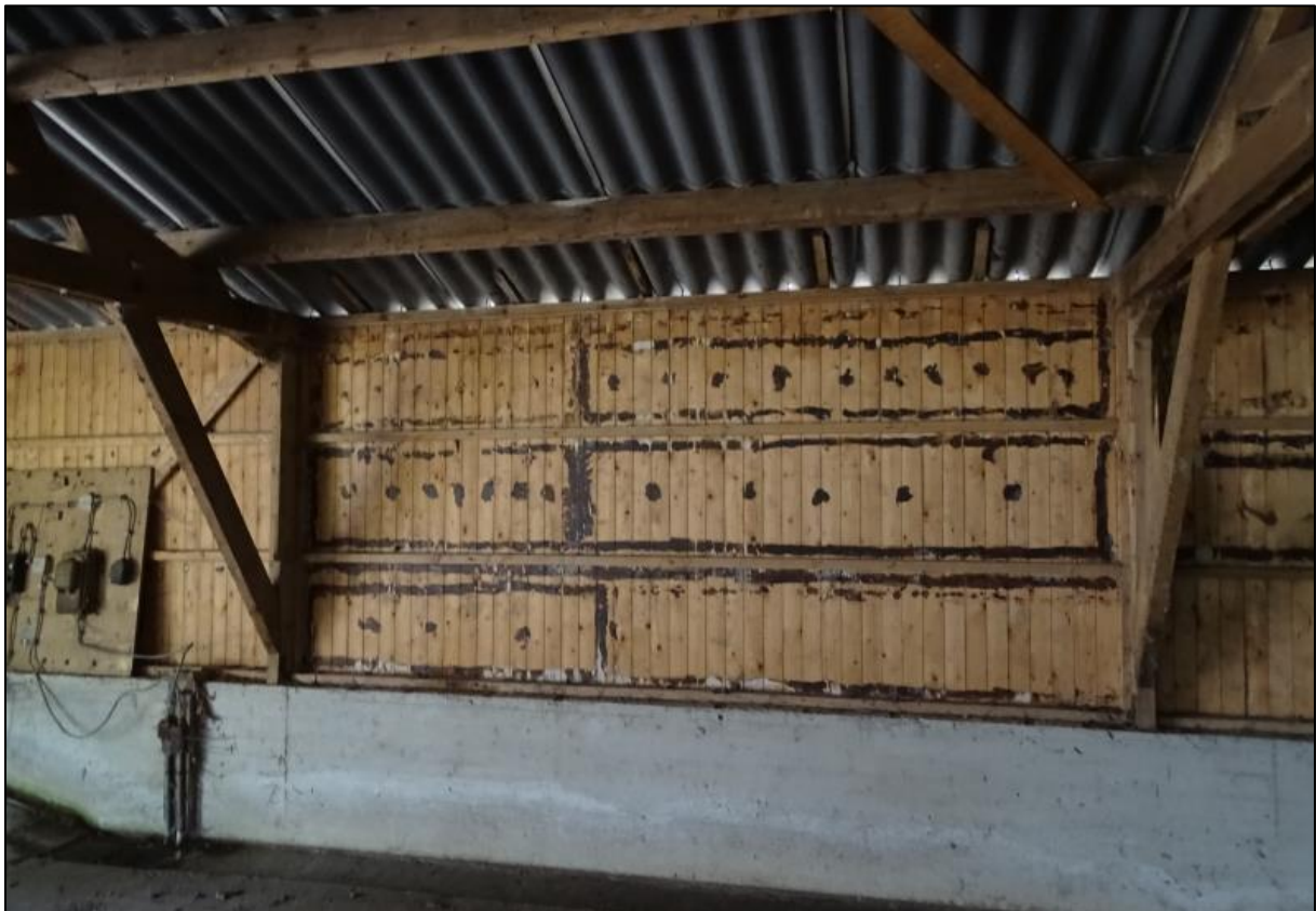
Figuur 5.5. Binnen aanzicht van de te slopen schuren 1 en 2, golfplaten dak en houten muren.
