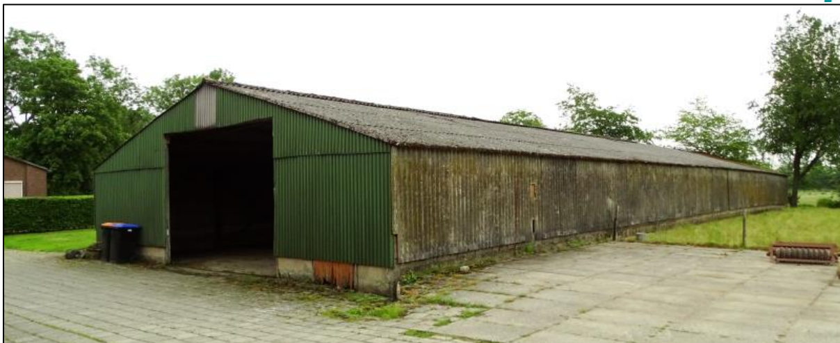
Figuur 2.2. Overzichtsfoto van de voorzijde van één van de voormalige kippenschuren (1) gezien vanuit zuidelijke richting.
