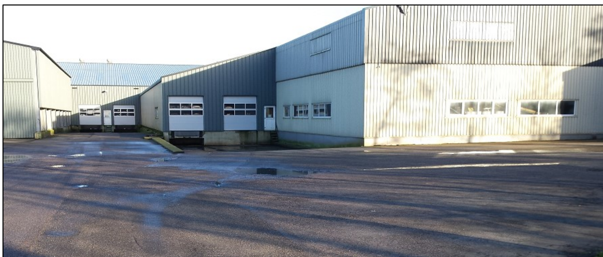
Afbeelding: Aanzicht doorgang naar gebouw 4 en gebouw 9 en 10
