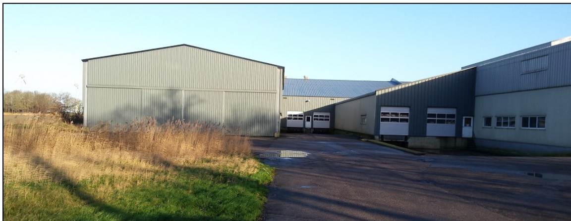
Afbeelding : Aanzicht gebouw 7, 9 en 10 en doorgang naar gebouw 4
