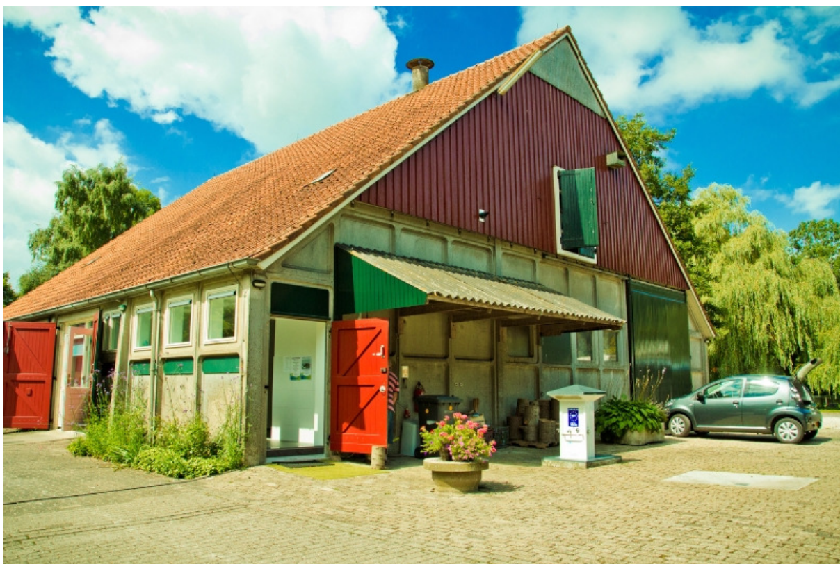
Foto 2: Schokbetonschuur (achterzijde – Noordoost kant)
