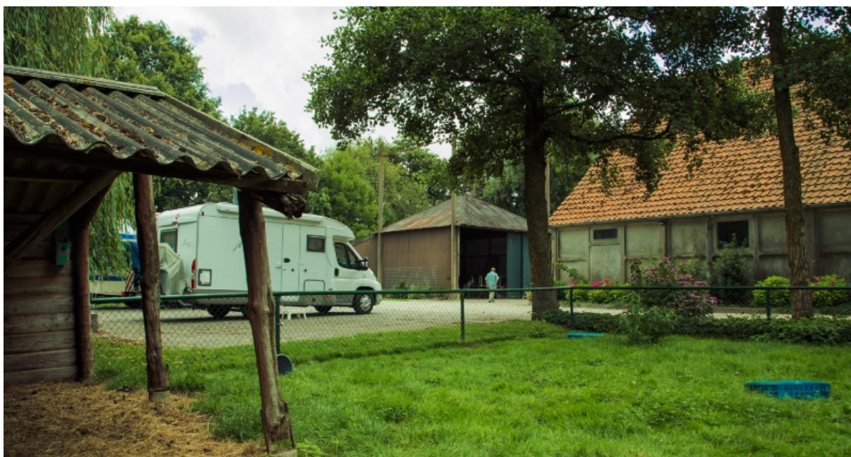
Foto 4: Zicht op schokbetonschuur en voormalige hooischuur
