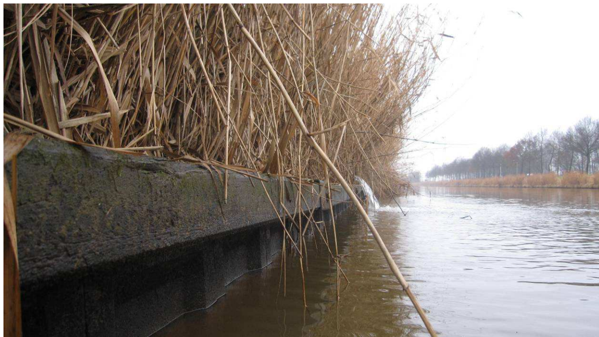
Figuur 6. Beschoeiing van de Zwolsevaart. Op de achtergrond is te zien hoe het water uit sloot 1 met kracht door een duiker in de vaart stroomt.
