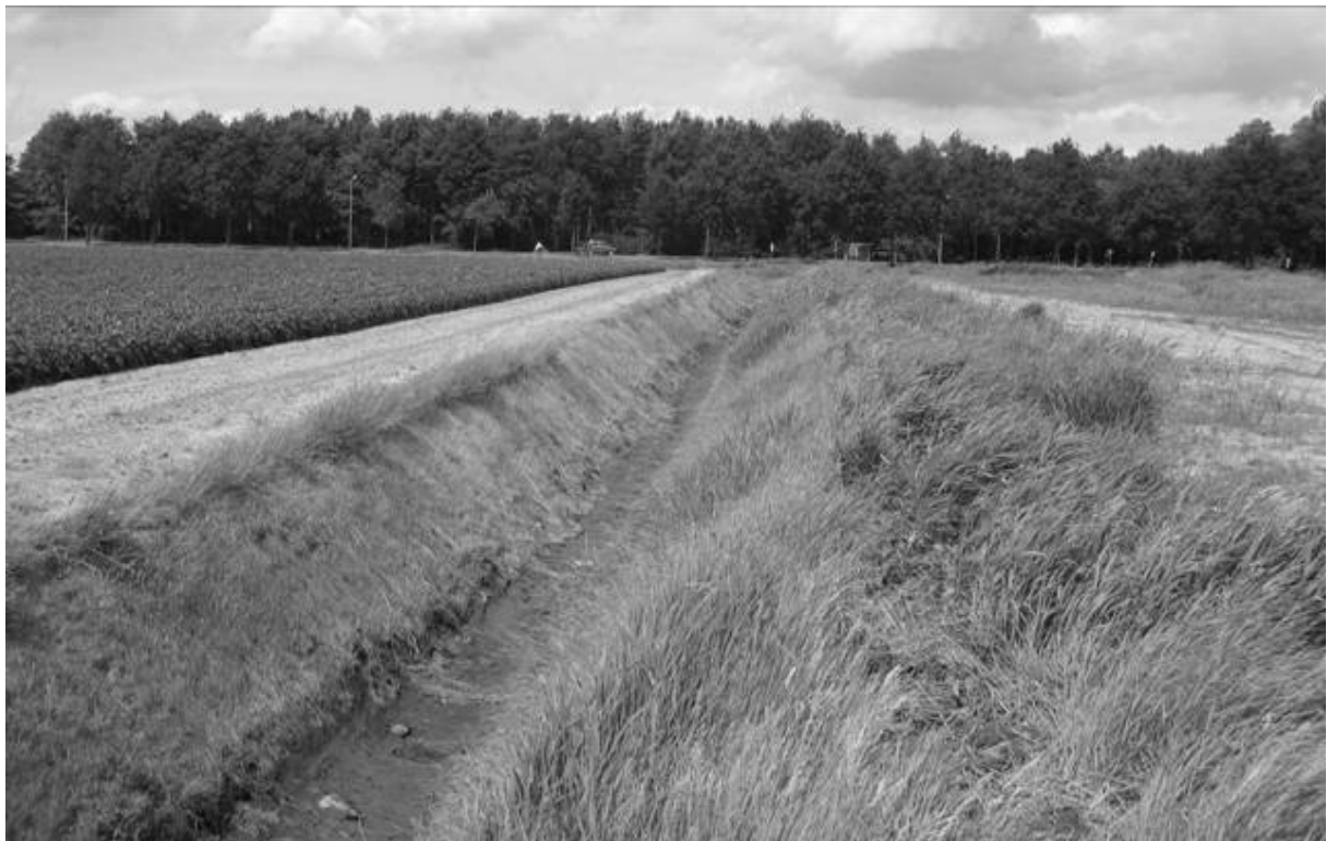
Figuur 12. Een groot deel van de Rugstreeppadpopulatie in de Noordoostpolder is afhankelijk van smalle sloten (Megahome.nl).
