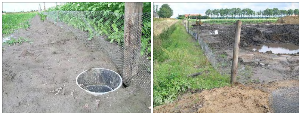
De ecologische verbindingzone in aanleg, een aardappelakker en mitigerende maatregelen voor de rugstreeppad
