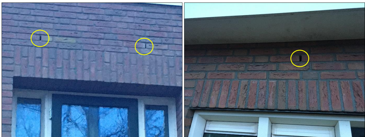
Voorbeelden van potentiële invliegopeningen in de bebouwing.
