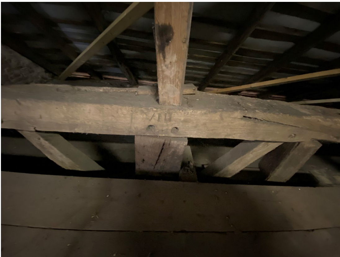
Afb. Gemarkte bovenplaat met gebintstaander en spreibanden
