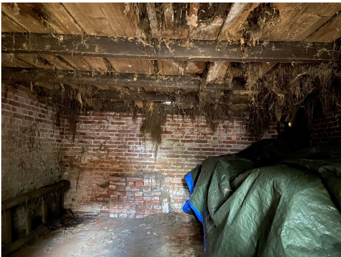
Afb. Interieur aardappelkelder met verdiept aangelegde vloer
