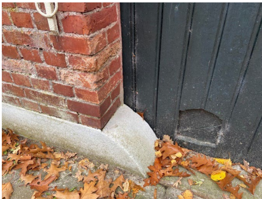
Afb. Veel details zichtbaar, schampsteen ter bescherming van de gevel, een kippen/poezen luikje en een gevelanker met ring om paard of koe aan vast leggen.
