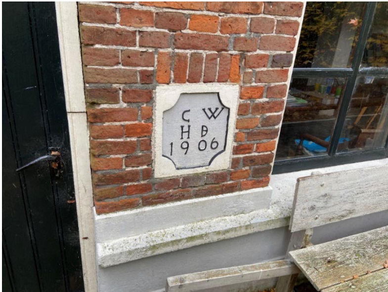
Afb. Plaquette met 1906 als datum en de initialen van de voormalige eigenaren. Deze datum is vermoedelijk het versteningsmoment van het hallenhuis. De wanden waren voor deze periode waarschijnlijk van vakwerk met leemvullingen
