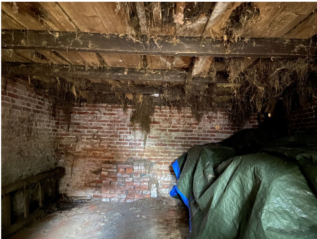
Afb. Interieur aardappelkelder met verdiept aangelegde vloer
