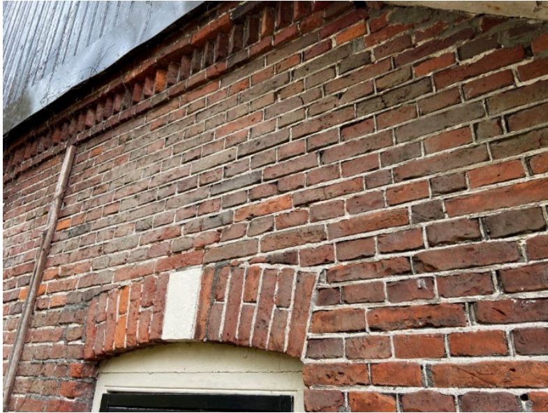
Afb. Steens metselwerk in kruisverband en een streks zaagtand net onder de topgevel
