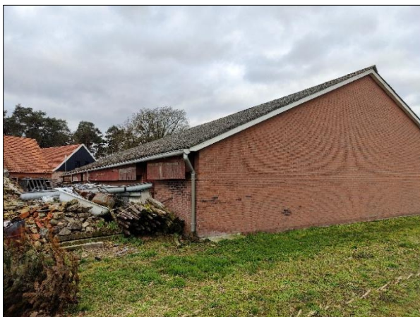
Foto: opgeslagen materialen naast de varkensstal.
