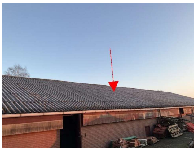
Golfplaten op het dak van de schuur
