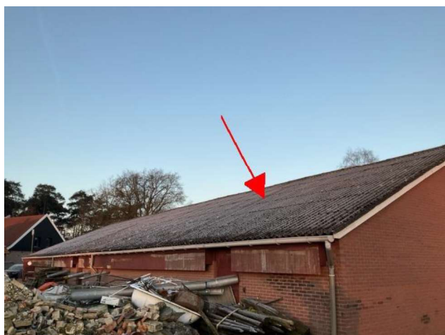
Golfplaten op het dak van de schuur
