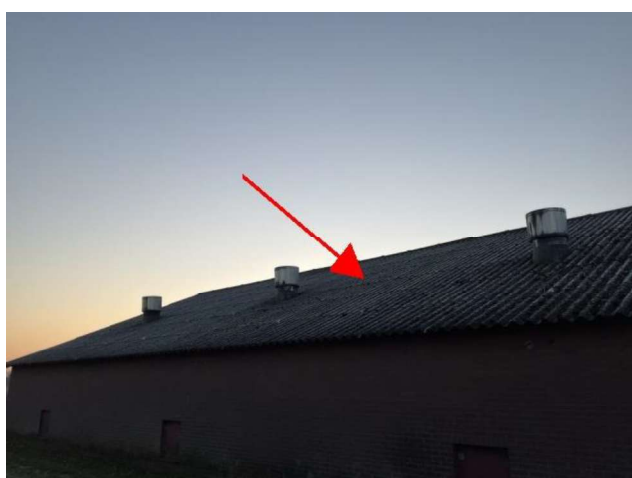
Golfplaten op het dak van de schuur
