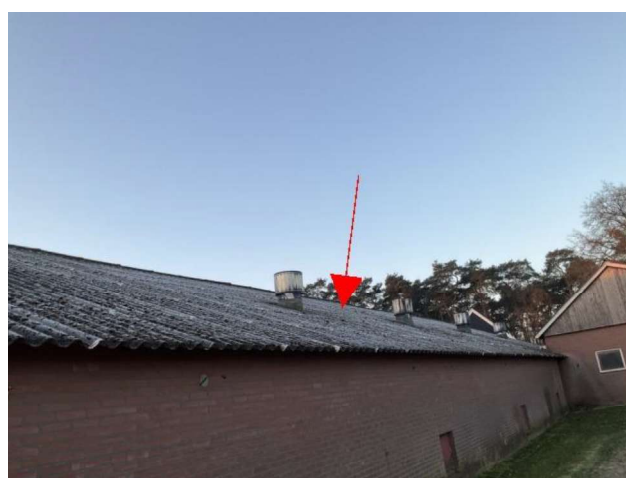
Golfplaten op het dak van de schuur
