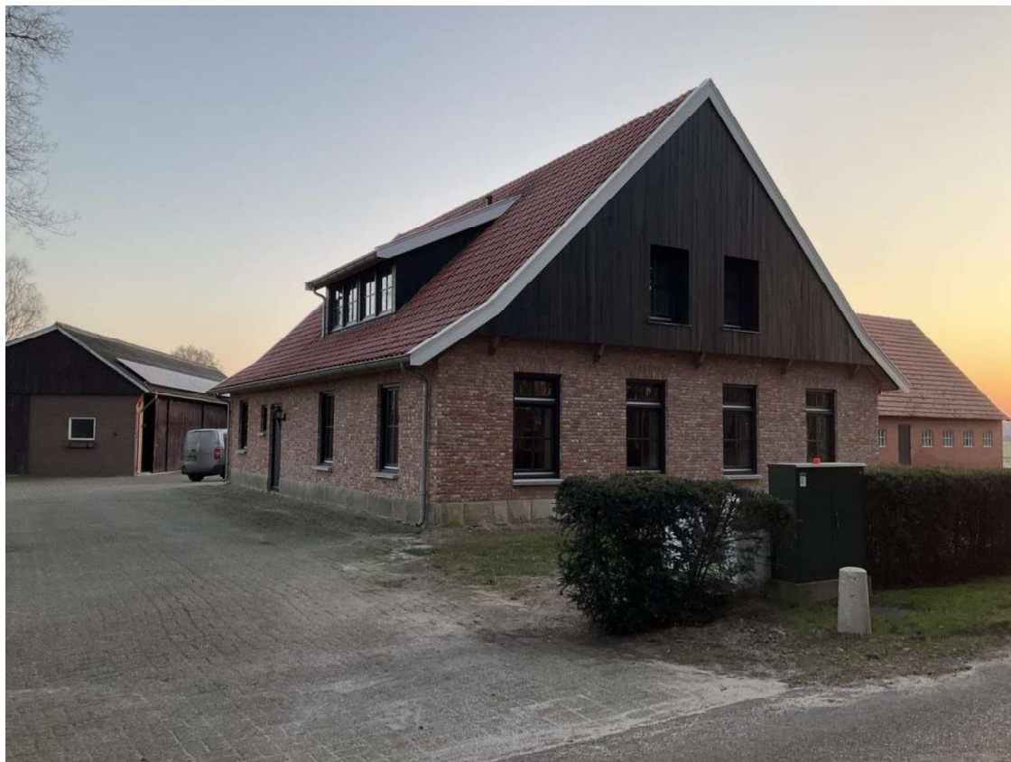
Schuur aan de Drielandweg 3 te Overdinkel
